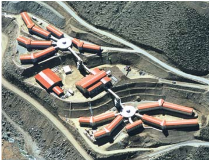
Hotel Minero, Minera Pelambres, Chile
