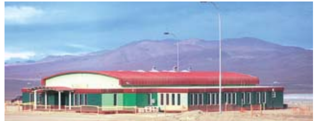
Oficina Operaciones Norte, Minera Escondida, Chile
